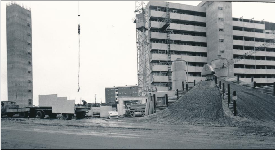
Hochhaus Klipperstraße, Aufzugsschacht
